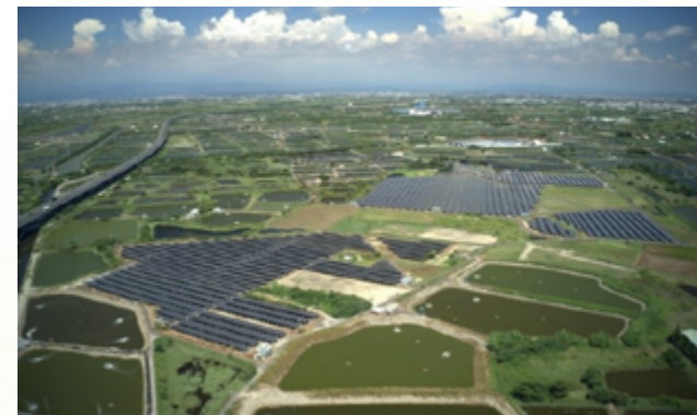
臺南北門 – 地面型 + 特高壓案場
