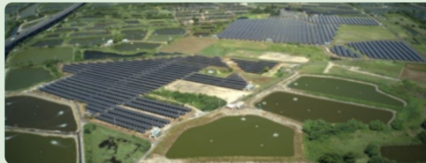
臺南北門 - 地面型 + 特高壓案場
