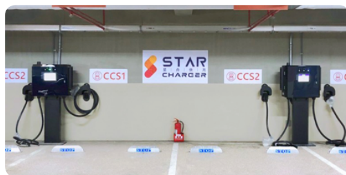
台北新光摩天大樓 17kW*5 樁
